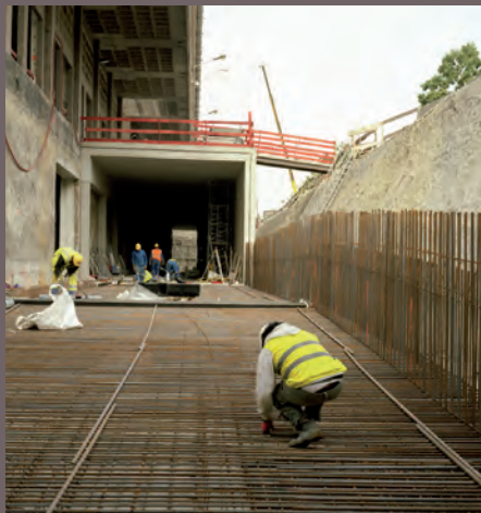
26 > LE CHANTIER MACDONALD - TUNNEL DE LIVRAISON 2011 © HANNAH DARABI
