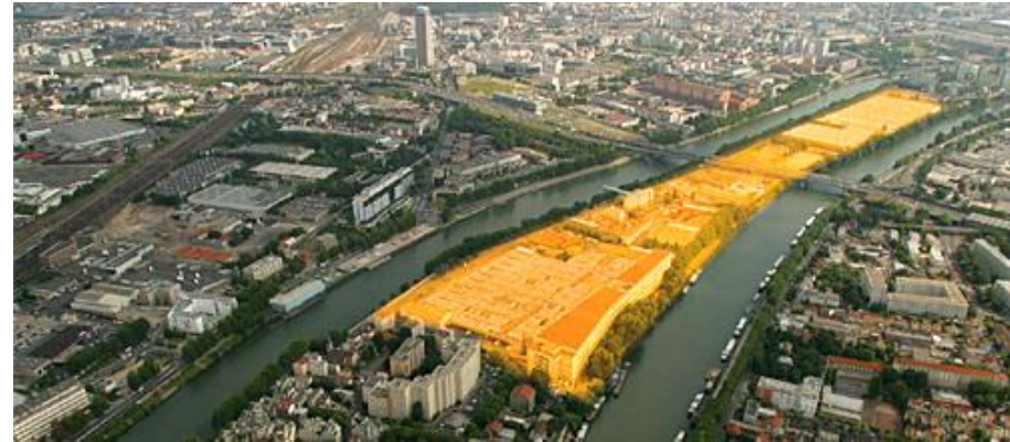
Écoquartier fluvial – Ile Saint Denis
