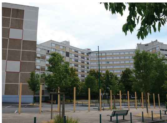
Déconstruction de la tour Iena-Svalis, Châteauroux
