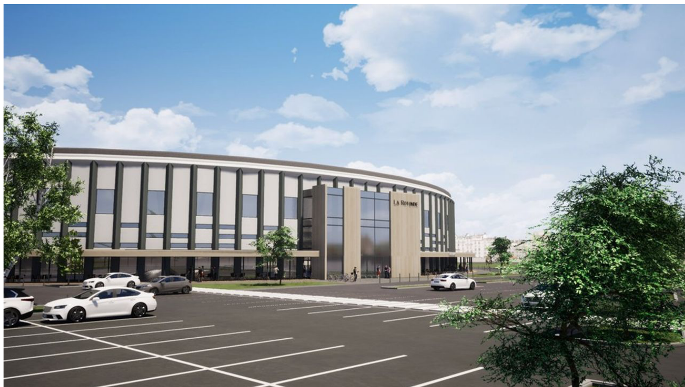
La Rotonde à Moulins-lès-Metz est un exemple de réhabilitation portée par la foncière Mayer. (Krypto Stone)
