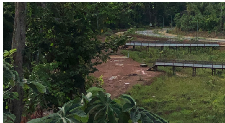
Bassin de compensation planté, écoquartier Georges Othily, Rémire-Montjoly, Guyane © Détails Paysage
