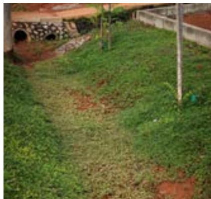
Noues végétalisées avec un couvre sol. © Détails Paysage
