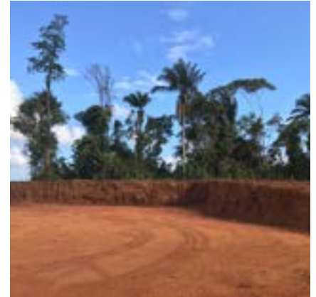
Terrassement avec maintien d'une parcelle boisée, écoquartier Vidal, Guyane © Détails Paysage
